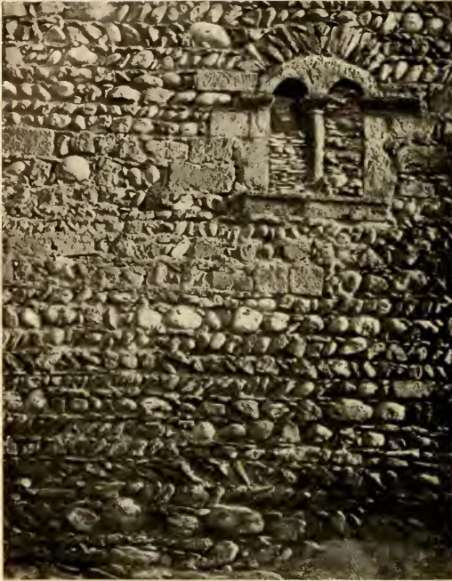
Fig. 345 — Porzione di una muraglia esterna del castello di Bramafam in Aosta (sec. XI)
